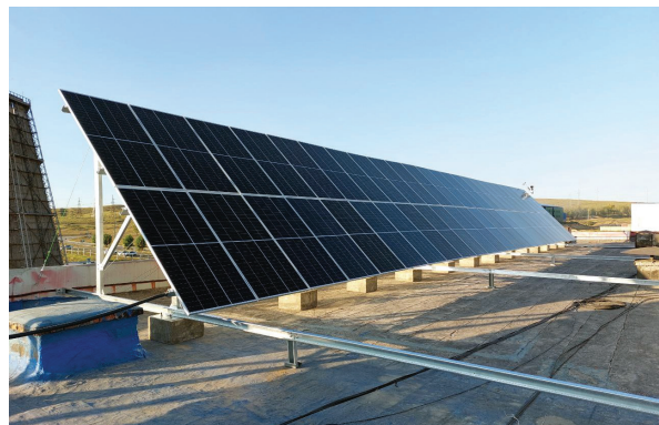
Нарны үүсгүүр ашиглаж төв конторын ЦЭХ-ийг 100% сэргээгдэх эрчим хүчээр хангаж байна
