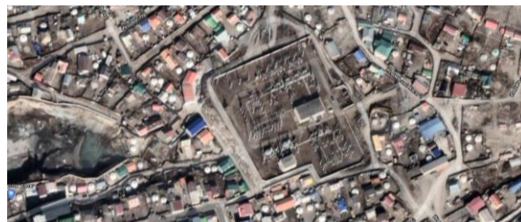
Зураг 2. Хороолол дунд байрлах дэд станц
