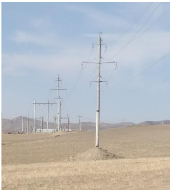
Зураг 6. 35кВ-ын тулгуур хоорондын байдал
