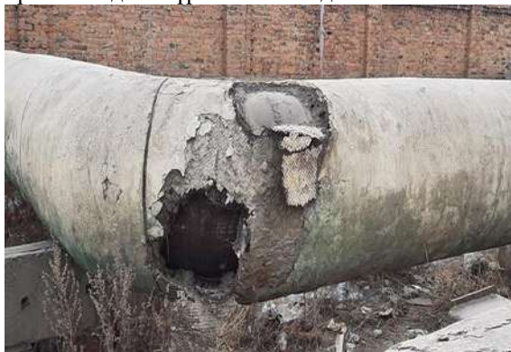
3.7-р зураг. Шугамын дулаалгын элэгдсэн байдал
