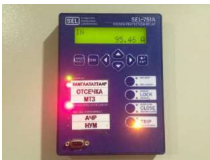
8-р зураг. РП-36А фидерийн SEL-751А микропроцессорын релений туршилтын үр дүн (I N -нэг фазын газардлагын гүйдлийн хэмжээ)
