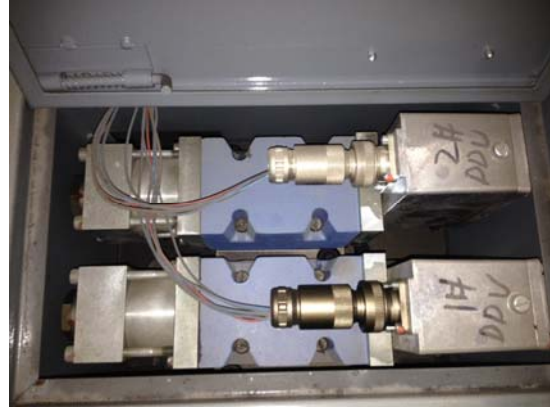
Зураг 7. DDV регуляторын суурилагдсан байдал.
