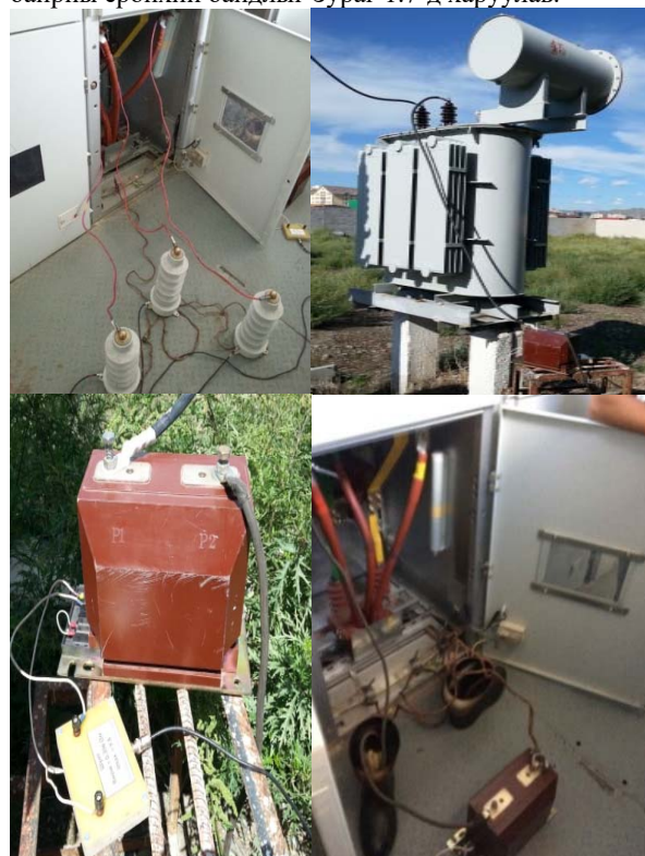
Зураг 1.7. 6-35 кВ-Ын шугам сүлжээний НФГ-ын туршилт хэмжилтийг явуулах ажлын байрны ерөнхий байдал
