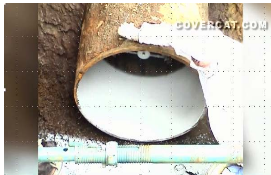
Зураг 5. Шугамын дотор гадаргуугөндөр температурт гэсвэртэй будгаар будаж байгаа байдал
