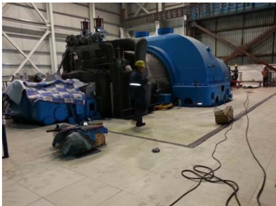
Зураг 1. Өндөр даралтат, нэг цилиндрт, нэг тэнхлэгт, дулаацуулгын отборт конденсацын турбин
