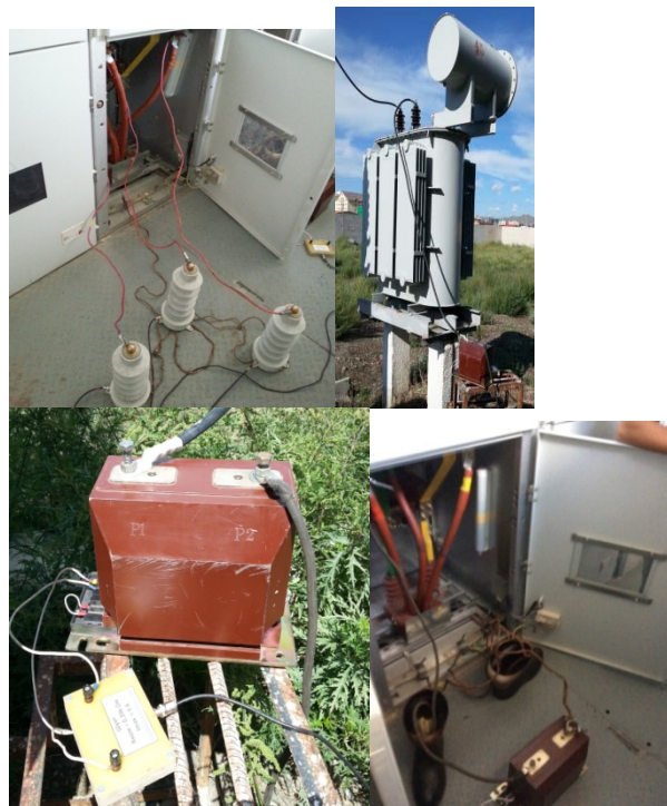
Зураг 3. 6-35 кВ-ийн шугам сүлжээний НФГ-ын туршилт хэмжилтийг явуулах ажлын байрны ерөнхий байдал
