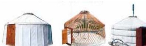
Дээвэр туурганы дотуур дулаалга Шалны “аяган” хэлбэрийн дулаалга Дээвэр туурганы гадуур дулаалга
