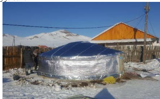
Зураг 5. Завхан аймгийн Тосонцэнгэл сумын төвд туршилт явуулсан гэрийн эсгийний гадуурх нэмэлт дулаалга хийсэн байдал
