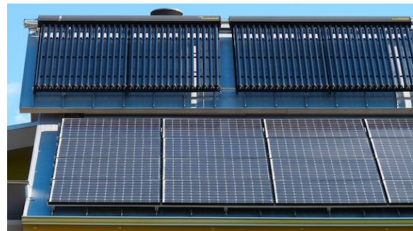
Зураг 5. Барилгын дээвэр дээр нарны зай болон коллекторыг хамт байрлуулсан байдал.
