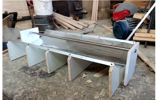
Зураг 1.2 Нарны коллекторыг угсарсан байдал
