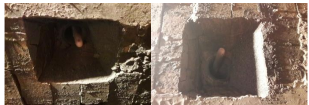
Зураг 8. Галын хотлын буцлах даврагын температур хэмжих термпарын байрлал
